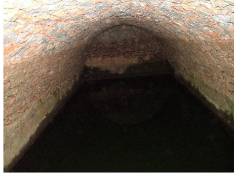
Fot. 12: Güney Sarıncı'nın haznesi
