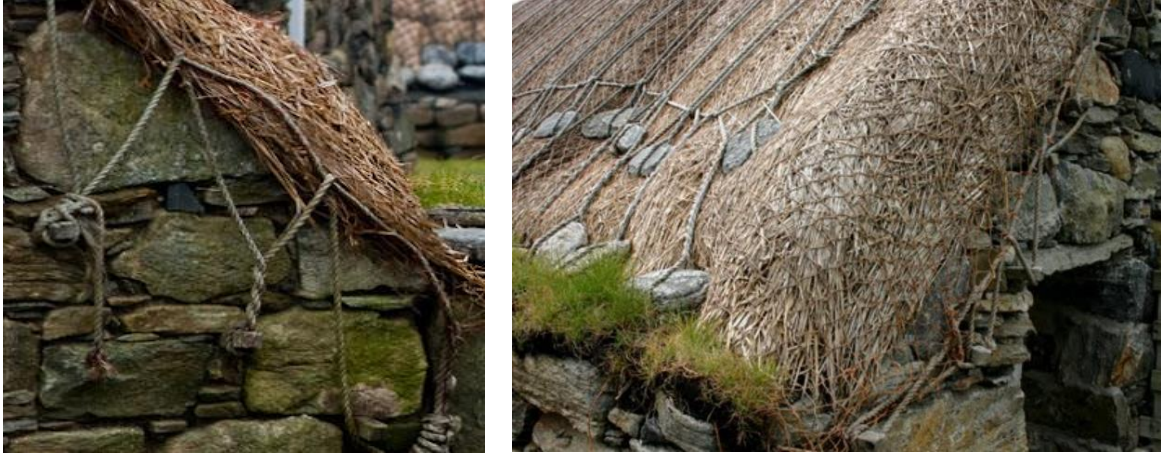
Şekil 3: Çatı örtüsünün saçaksız duvara bağlanma örneği [URL-2]
