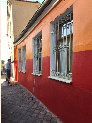
Fotoğraf 7: 50 No'lu yapı yüzey renklendirme uygulaması.
