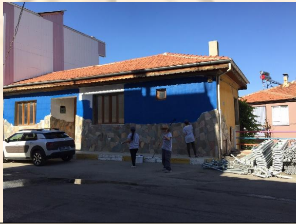
Fotoğraf 3: 48 No'lu yapı yüzey renklendirme uygulaması.
