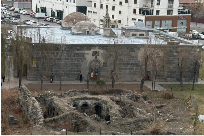
Şekil 4. Kөлük Camii ve Medresesi Kuzey cephe (Şahin, 2024)
