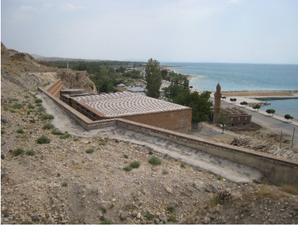
Fot. 1: Yapı, kuzey yönde yer alan istinat duvarı ve kurşun kaplı damın görünümü.
