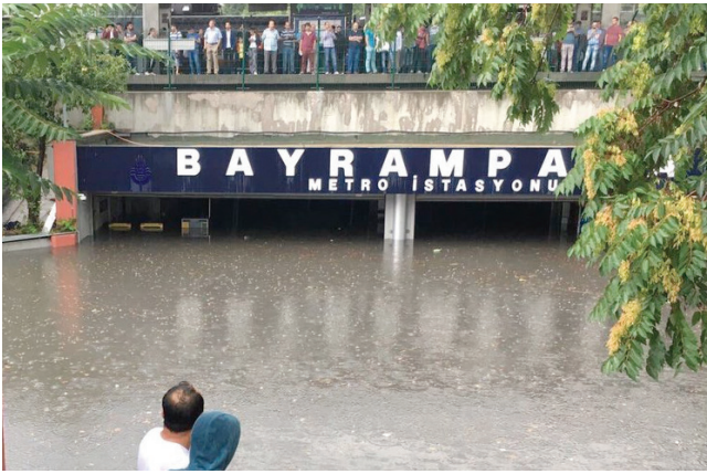
Şekil 2. 18 Temmuz 2017 tarihinde meydana gelen şiddetli yağış sonucu Bayrampaşa Metro İstasyonu'nun sular altında kalması
