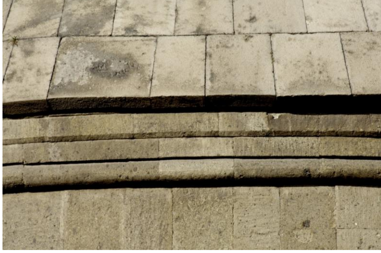
Resim 8: Çengâl (?) (Cimcime) Hatun Kümbeti saçak silmeleri
