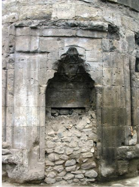
Resim 5:Çengâl (?) (Cimcime) Hatun Kümbeti girişi (2011 Restorasyonu Öncesi)
