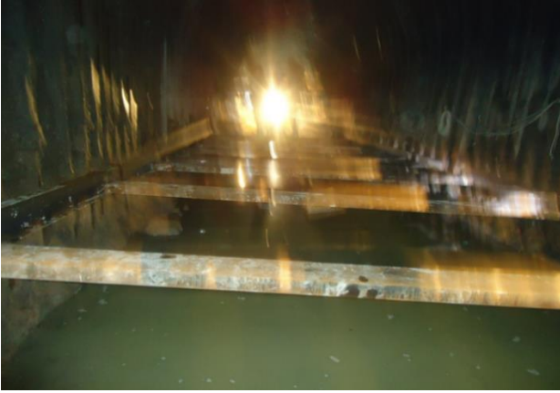
Şekil 4. Tünel tabanına biriken su
