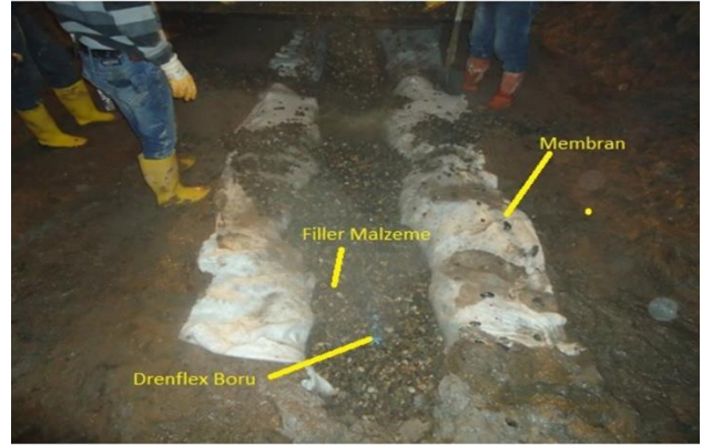
Şekil 6. Drenaj kanalları yapımı
