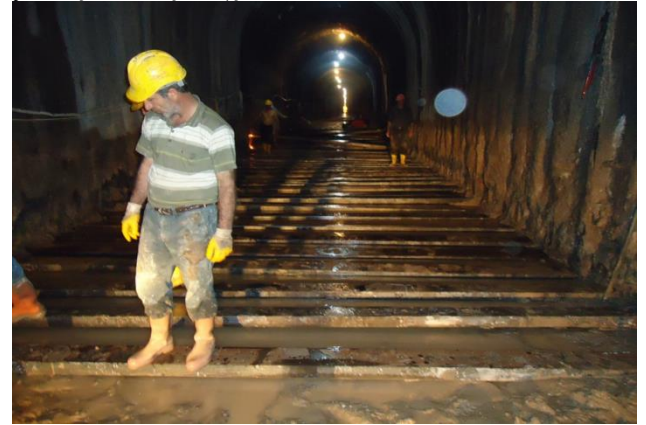
Şekil 11. İksa ayaklarının gergiler ile sabitlenmesi
