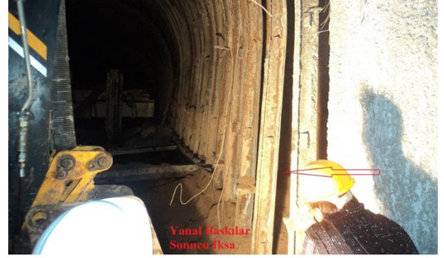
Şekil 10. Bükülen iksaların tıraşlanma işlemi
