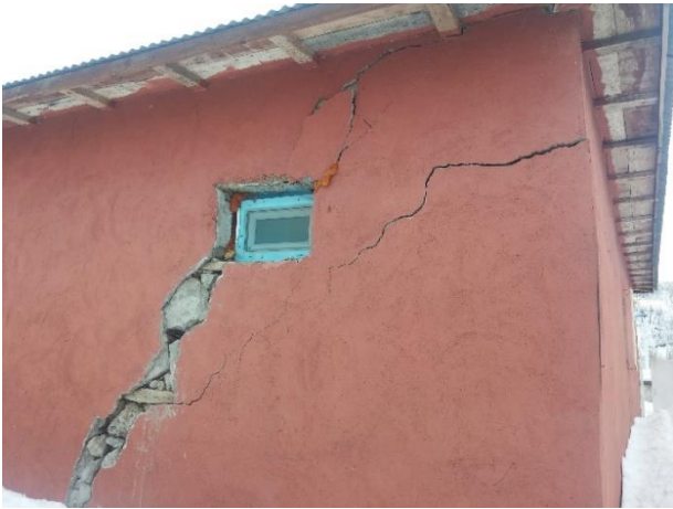
Şekil 10. Düzlem-içi hasar
