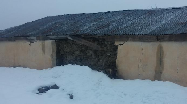
Şekil 7. Düzlem-dışı göçme
