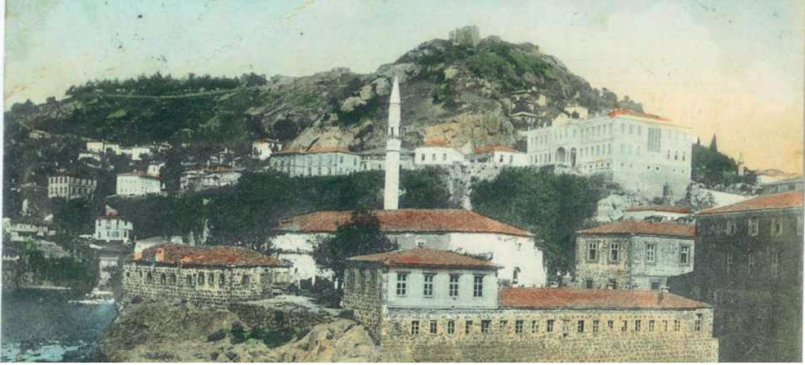
Fotoğraf 2: Sultan Selim Camii Külliyesi'nin güneybatıdan görünüşü (Öndeki yapı Fehmiye Medresesi)
