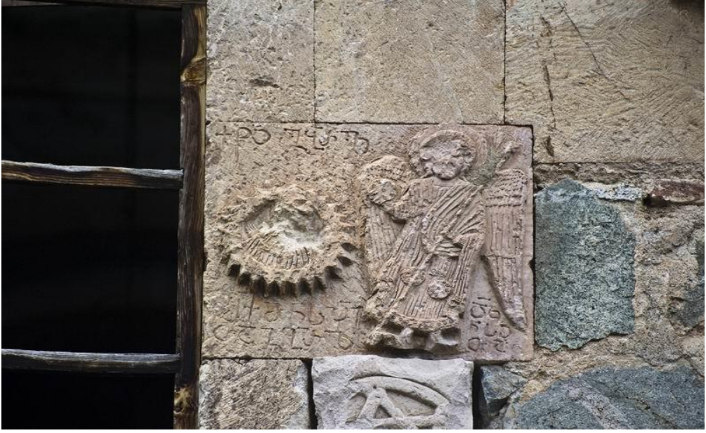
Foto 8: Dolishana Kilisesi, Güney Cephesi ( https://maps.nekeri.net/ )
