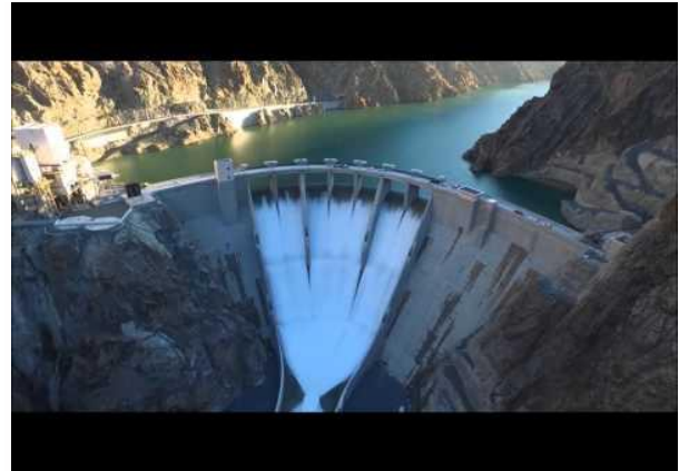
Resim 4. Artvin barajının mansapdan görünüşü [16]
