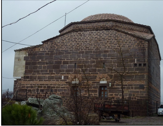
Resim 4: Yapının batı cephesinde, sıralı taş, tuğla alması örgülü yuvarlak kemerler (Kuleli, 2013).
