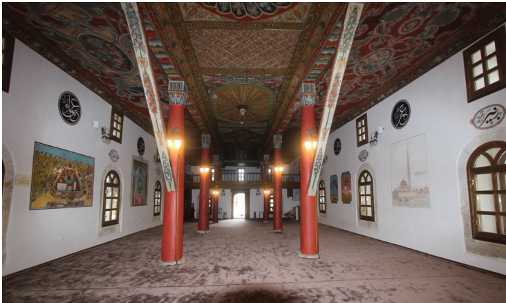
Fotoğraf 5: Ahşap direkleri ve mihrap yönünden ikinci sırayı oluşturan direkten tavana atılan destek (2023)
