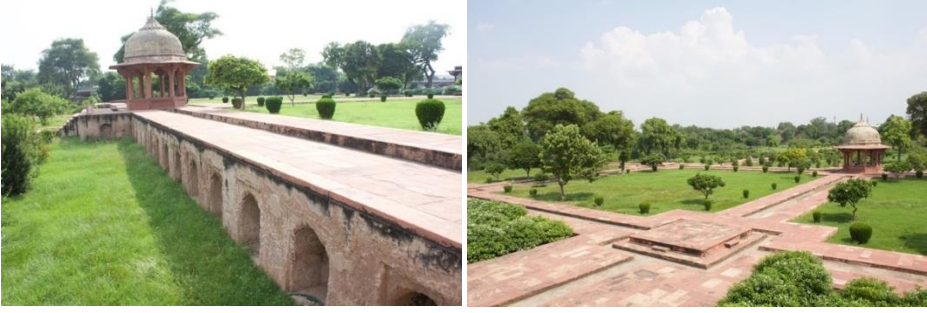
Görsel 9.-10 Aram Bağ Çatri, Su Kanalları ve Yürüyüş Yolları (Özler Kaya, 2023)
