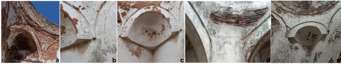
Şekil 14. Piyâde Kışla-i Hümayûnu Hamamı Kubbeye Geçiş Elemanları ile Tezyinatlara ait Fotoğraflar, 2021: a-b-c. Ilıklık, d. Sıcaklık Ana Mekânı; e. Halvet, 2021
