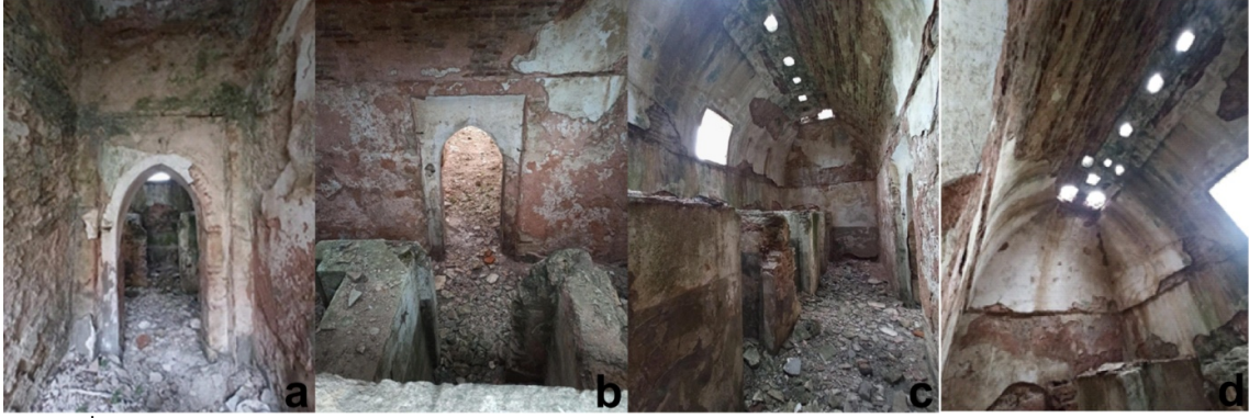
Şekil 11. Piyâde Kışla-i Hümayûnu Hamamı Helası İç Mekân Fotoğrafları, 2021
