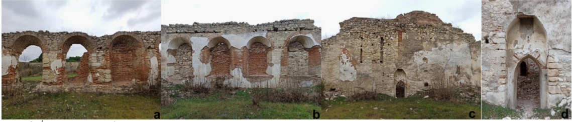
Şekil 9. Piyâde Kışla-i Hümayûnu Hamamı Soyunmalık İç Mekân Fotoğrafları, 2021: a. Soyunmalık İç Mekânı Güneybatı Cephesi; b. Soyunmalık İç Mekânı Kuzeydoğu Cephesi; c. Ilıklık Tarafı Cephesi; d. Soyunmalıktan Ilıklığa Giriş Kapısı
