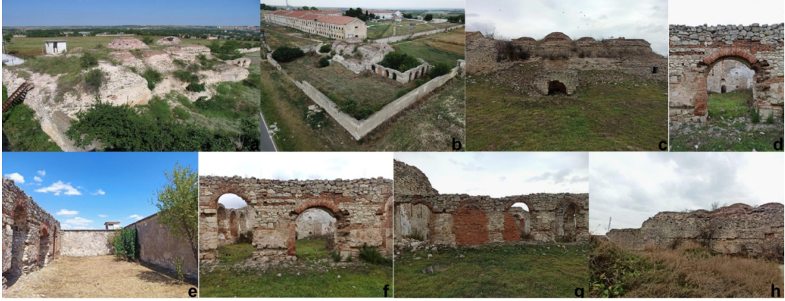
Şekil 8. Piyâde Kışla-i Hümayûnu Hamamı Fotoğrafları, 2019-2021: a. Güneybatı- Kuzeybatı Cepheleri; b. Güneybatı ve Güneydoğu Cephesi; c. Güneybatı Cephesi; d-e Güneydoğu Cephesi; f-g. Güneybatı Cephesi; h. Kuzeydoğu Cephesi
