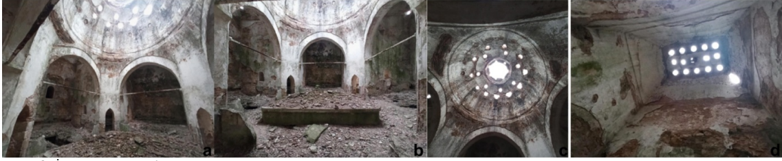
Şekil 12. Piyâde Kışla-i Hümayûnu Hamamı Sıcaklık İç Mekân Fotoğrafları, 2021
