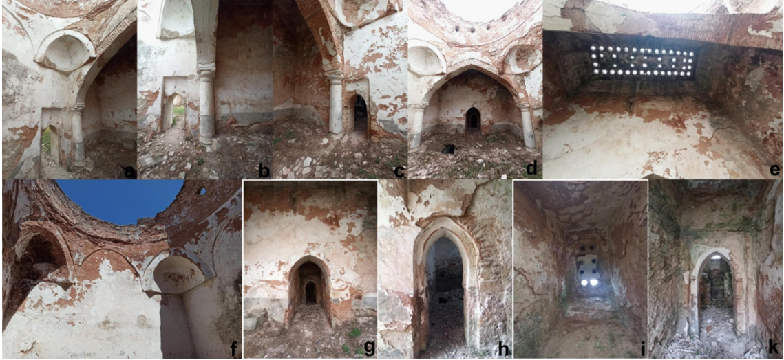
Şekil 10. Piyâde Kışla-i Hümayûnu Hamamı Ilıklık İç Mekân Fotoğrafları, 2021: a-b. Ilıklıktan soyunmalığa geçiş kapısı, ılıkık eyvanı sütunu ve kemeri ile tromp; c. Ilıklıktan sıcaklığa geçiş kapısı, ılıkık eyvanı sütunu ve kemeri ile tromp; d. Ilıklık eyvanı sütunları ve kemeri ile yıkılmış kubbe, ılıkıkklar ve tromplar; e. Ilıklık eyvanı aynalı tonozu ve ılıkıkkları; f. Ilıklık ana mekânı kuzeydoğu duvarı, yıkılmış kubbe ve geçiş ögesi olan tromplar; g. Ilıklık eyvanından tıraşlıklar ve helaya geçiş holü; h. Ara hole açılan tıraşlık mekânı kapısı; i. Tıraşlık üst örtüsü aynalı tonozu ve ılıkıkkları; k. Holden helaya geçiş kapısı
