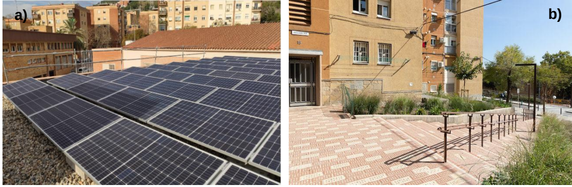
Şekil 6: a) Trinitat Nova'da çatı güneş paneli uygulaması (Azimut360, 2019), b) Trinitat Nova'da su geçirgen yüzey kaplamaları ve bitkilendirme (Socotec, 2019)
