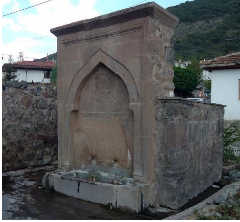
Fotoğraf 1. Belören Köyü Çeşmesi Genel Görünüm
