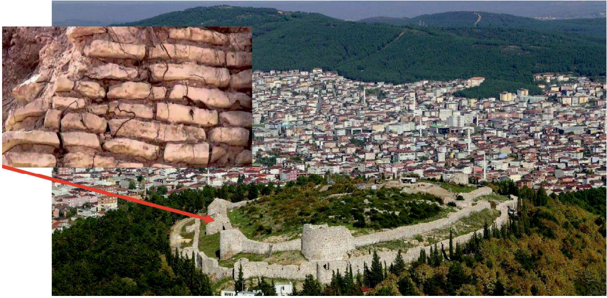
Şekil 9. Aydos Kalesi ve duvarlarında kullanılan kuvarsitlerin görünümü. Figure 9. View from quartzites used in the walls of Aydos Castle.
