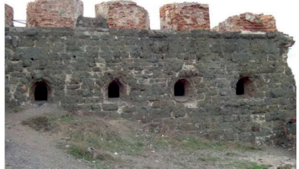
Şekil 30. Rumeli Feneri ve Garipçe Kaleleri ile duvarlarında kullanılan Üst Kretase volkanitlerinden bazaltik-andezit bileşimli, volkanik breş ve lavlar.
