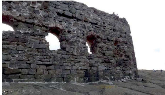
Şekil 30. Rumeli Feneri ve Garipçe Kaleleri ile duvarlarında kullanılan Üst Kretase volkanitlerinden bazaltik-andezit bileşimli, volkanik breş ve lavlar.
