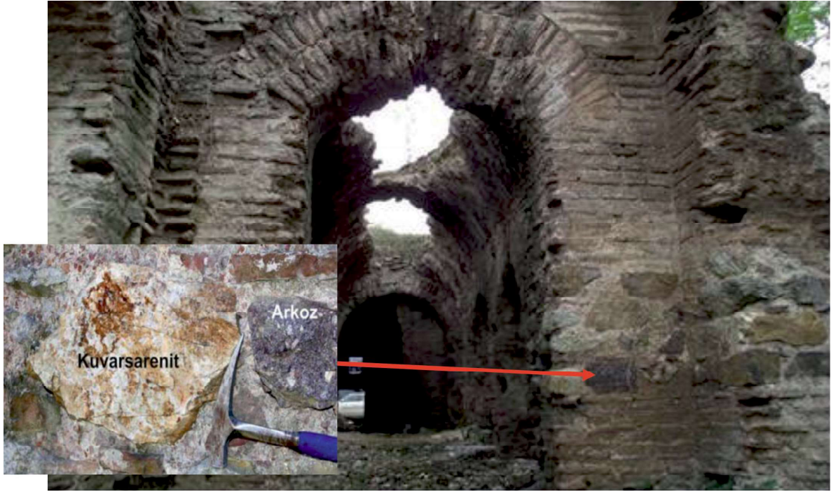
Şekil 5. Damatrix Sarayı ve duvarlarında kullanılan arkozik kumtaşlarının görünümü (Öngen ve diğ., 2011a). Figure 5. View from arkosic sandstones used in the walls of Damatrix Palace (Öngen et al., 2011a).
