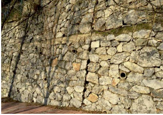
Şekil 19. Yol yarmasındaki istinat duvarı (soldaki) ve sitenin bahçe duvarında (sağdaki) kaba yonu taşı olarak kullanılan Devoniyen yumrulu kireçtaşları (Kavacık-Kanlıca yolu).
