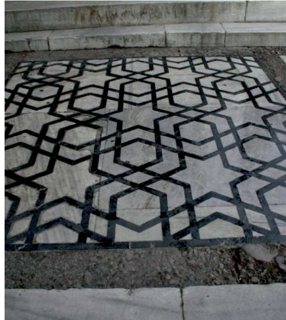
Şekil 14. Sultanahmet Camii avlu girişindeki yer döşemesinde kullanılan beyaz kalsit damarlı, siyah renkli Devoniyen kireçtaşları.
