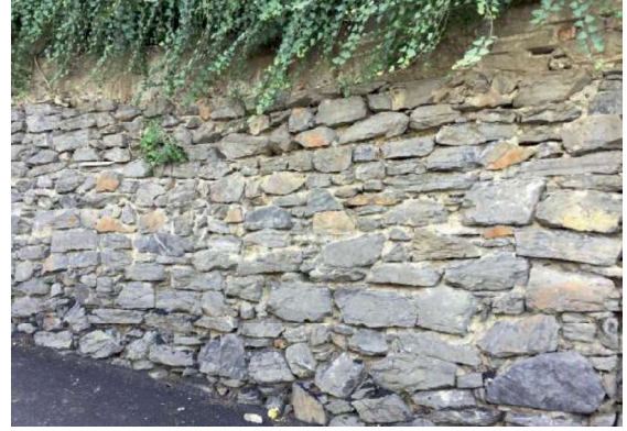
Şekil 19. Yol yarmasındaki istinat duvarı (soldaki) ve sitenin bahçe duvarında (sağdaki) kaba yonu taşı olarak kullanılan Devoniyen yumrulu kireçtaşları (Kavacık-Kanlıca yolu).
