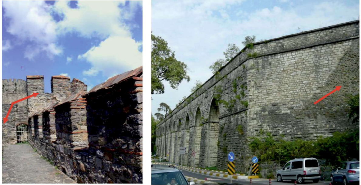
Şekil 23. Rumeli Hisarı duvarları ile burçlarında (soldaki) ve Bahçeköy Sultan I. Mahmud Su Kemerini'nin (sağdaki) duvarlarında kullanılan Karbonifer yaşlı mikalı kumtaşları.
