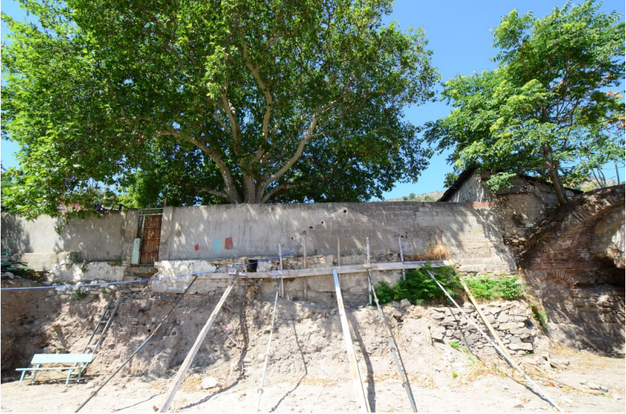
Fot.9- Avluyu batıdan sınırlayan duvarın temizlik çalışmaları sonrası görünüşü.
