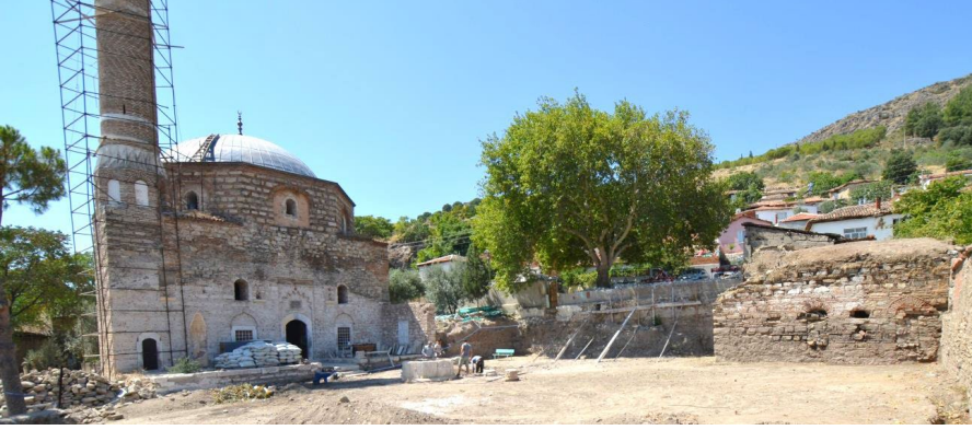
Fot.1- Cami ve avludaki yapının kuzeydoğudan görünüşü.
