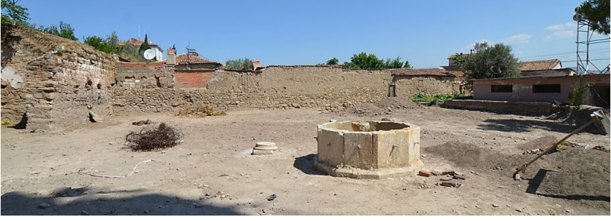
Fot.18- Temizlik çalışmaları sonrası avlu.
