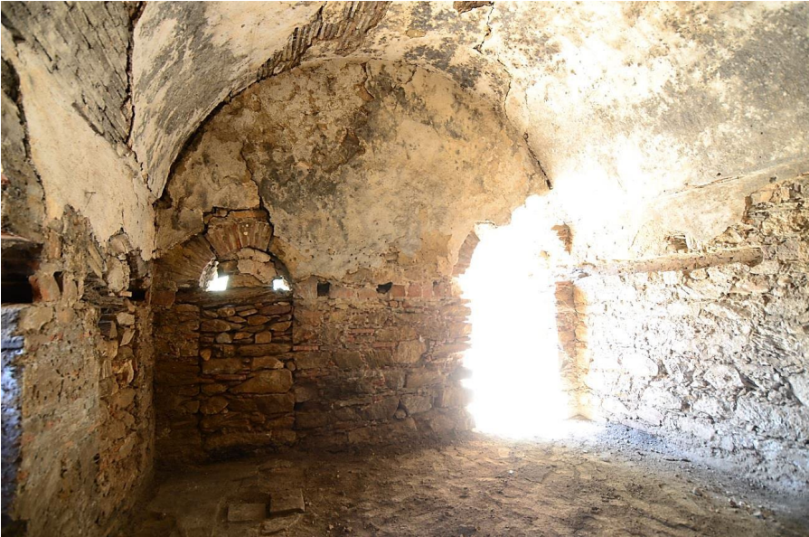
Fot.15- Mekanın güney duvarı, giriş ve pencere.
