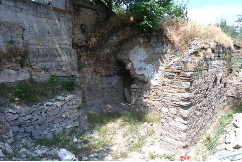
Fot.13- Avlunun kuzeydoğu köşesindeki yapının temizlik çalışması öncesi görünüşü.
