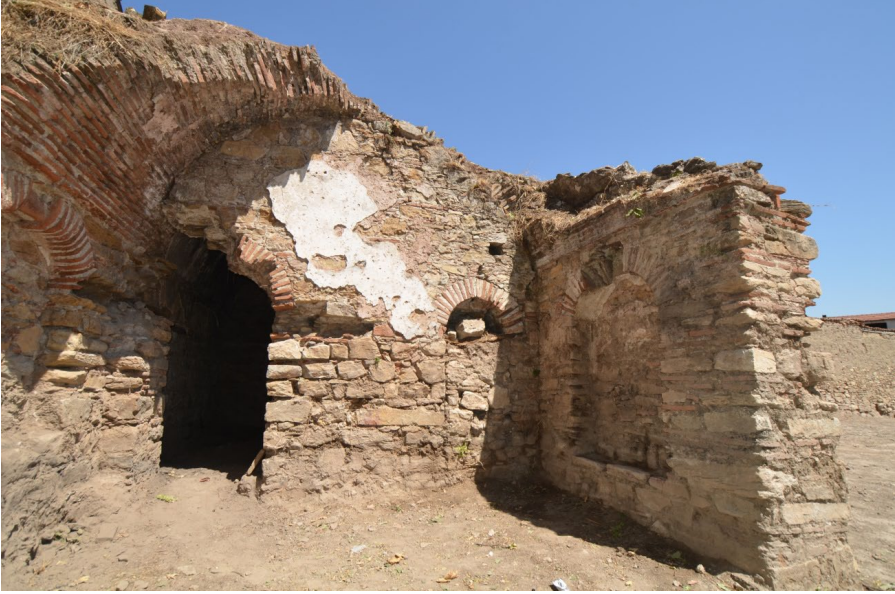
Fot.14- Avlunun kuzeydoğu köşesindeki yapının temizlik çalışması sonrası görünüşü.
