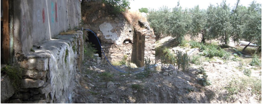
Fot.6- Avlunun kuzeybatı köşesindeki yapının temizlik çalışmaları öncesi görünüşü.
