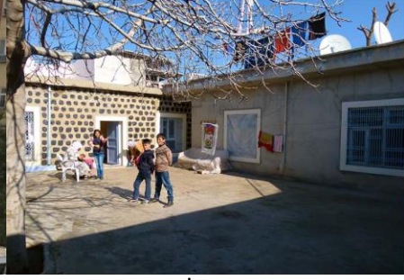
Fotoğraf 10. Yeni İnşa Edilen Arasında Kalan Avlulu Konut
