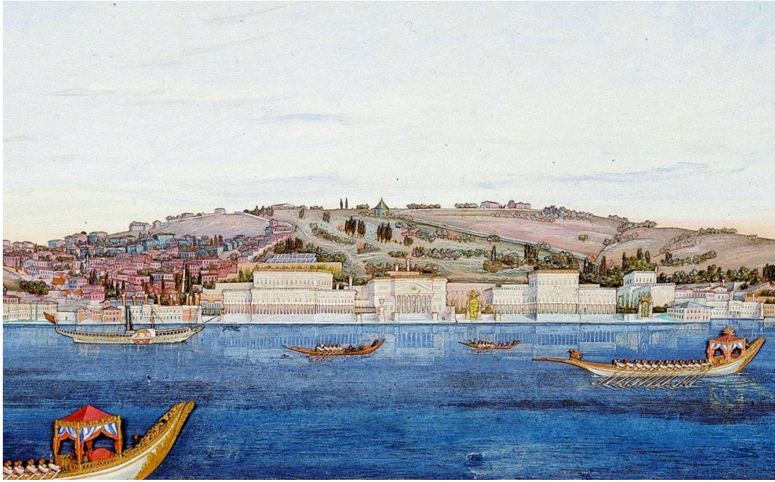
Görsel 9: Eski ahşap Çırağan Sarayı'nın arka bahçesinde, sol arkadaki duvara yaslanan cam çatılı yapı. 45 Mıgırdiç Melkon, yağlı boya, 1844
