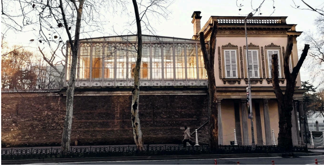
Görsel 6: Dolmabahçe Sarayı'nın dış duvarı üzerinde William Smith tarafından tasarlanan Camlı Köşk'ün saray duvarları dışından görünüşü
