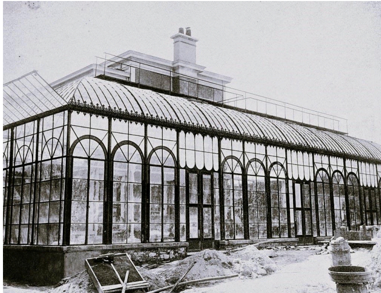
Görsel 25: Dönemin sadrazamı Cevad Paşa'nın Nişantaşı'ndaki konağında, "Demircibaşı Mösyö Akıla ve saray tamirhanesinde müstahdem demirci ustalar marifetiyle inşa edilmiş olan demir limonluğun harem dairesi tarafından görünüşü."
