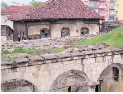
Ek. 25. İshak Fakih Medresesi Restorasyon Öncesi Orijinal Kat Durumu ( www.haberler.com/yerel/ishak-fakih ).
