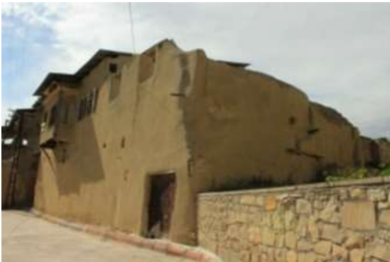
Foto 3b. Mehmet Çiftçi evi güneydoğu cephe (Photo 3b. Mehmet Çiftçi houses the southeast front)
