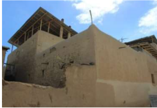
Foto 2c. Kuzeydoğu cephe (Photo 2c. Northeast front)
