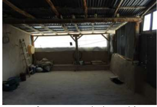
Foto 2m. Yarı açık dam mekânı kuzey cephe (Photo 2m. Semi-open roof space north front)
