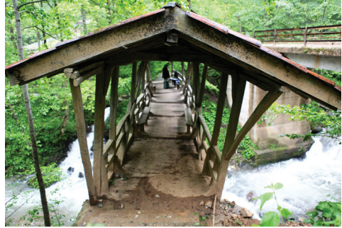
Fot. 13: Kiremitli Köprü; batı cephe (giriş) ve tabliye.
