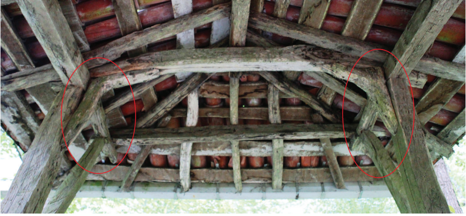
Fot. 28: Kiremitli Köprü Doğu Girişte Çatı Ayrıntısı. (İşaretli kesim: Çatı kirişine sonradan yapılan ilave.)
