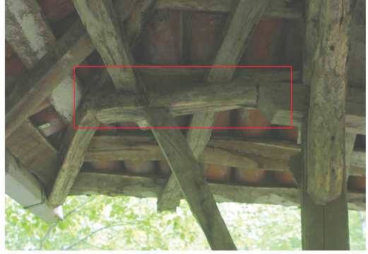
Fot. 26: Kiremitli Köprü; Doğu Girişte Çatı Ayrıntısı. (İşaretli kesim: Çatı kirişine sonradan yapılan ilave.)
