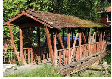
Fot. 41: Kastamonu - Bozkurt İlîşi Cumayanı Köprüsü.
