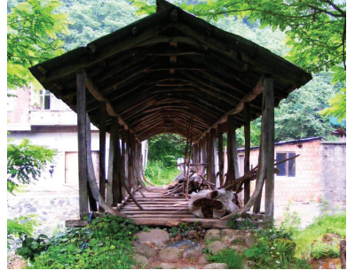
Fot. 34: Giresun, Uzkara-Sayca köyleri sınırında Ezirkan (Dillioğlu) Köprüsü, batı cephe.
