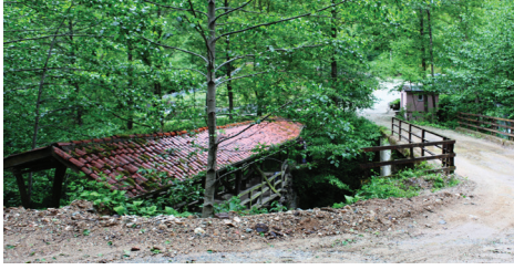
Fot. 2: Kiremitli Köprü (güneybatı/menba yüzü); betonarme köprü ve Çiz.1'de 3 no. 'lu değirmen.
