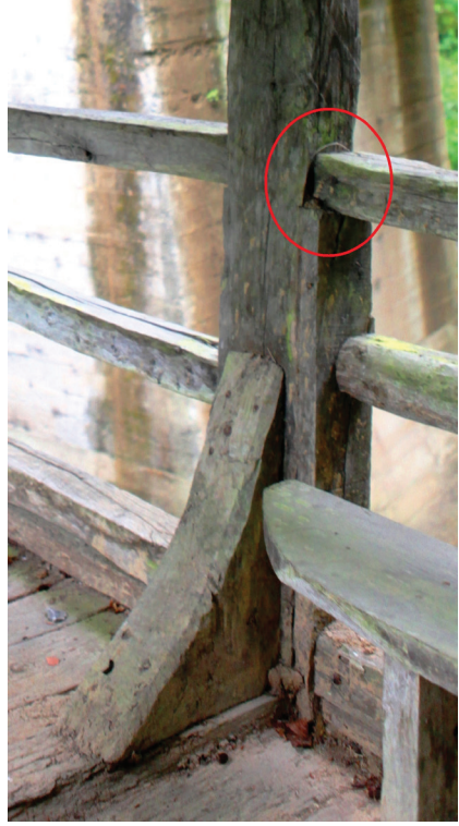
Fot. 21: Kiremitli Köprü; Menba Yüzü Korkuluk Ayrıntısında Kertmeli Uç Birleşme.
