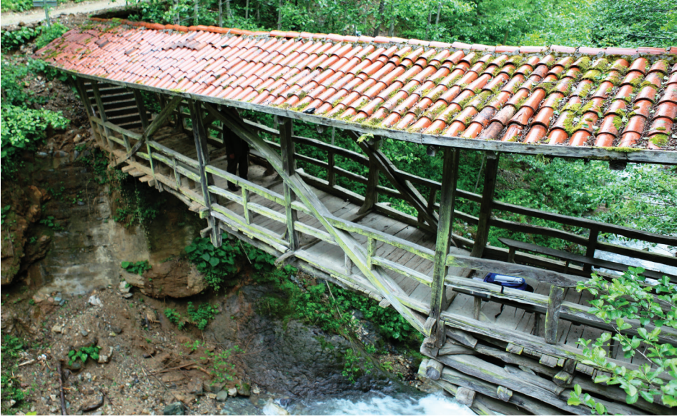
Fot. 11: Kiremitli Köprü; menba (güney) cepheye güneydoğudan bakış.
