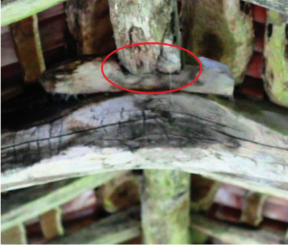
Fot. 25: Kiremitli Köprü; Gergi - Yastık Arasında Kanallı Geçme Ayrıntısı.
