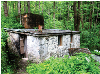
Fot. 8: Köprü'nün menba tarafında, betonarme olarak yenilenmiş değirmen. (Çiz.1'de 4)
