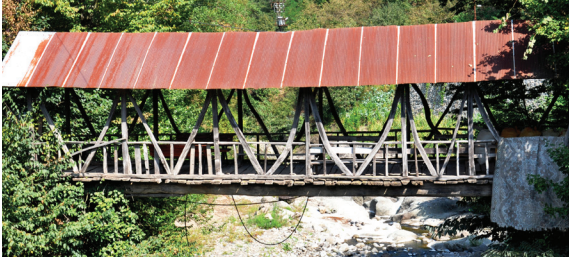
Fot. 40: Ordu - İkizce, Çandır Köprüsü. (Şerife Tali'den)
