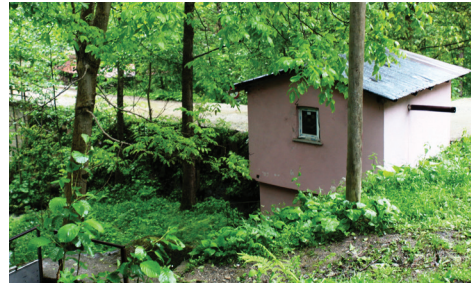
Fot. 7: Köprü'nün menba tarafında, betonarme olarak yenilenmiş değirmen. (Çiz.1'de 3)
