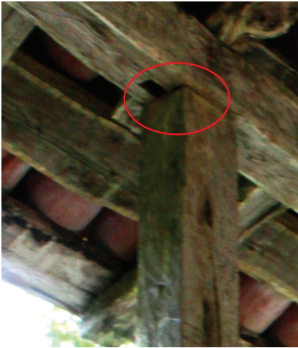
▲ Fot. 18: Kiremitli Köprü; Menba Yüzü, Korkuluk Ayrıntısı. (1- Düz boy birleştirme 2- Pahlı (şevli) boy birleştirme 3- Kanallı geçme 4- Düz en birleştirme.)
