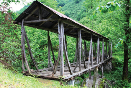
Fot. 36: Giresun - Lapa köyü Ahmet Ağa Köprüsü. Kuzey ve batı (mansab) cepheler.
