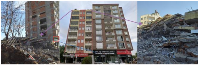
Şekil 4. Toptan göçmeye maruz kalmış betonarme yapının deprem öncesi ve sonrası durumu
