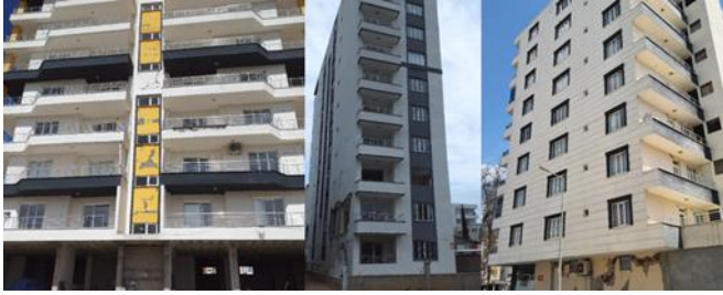
Şekil 3. Hafif hasarlı çok katlı betonarme yapı örnekleri
