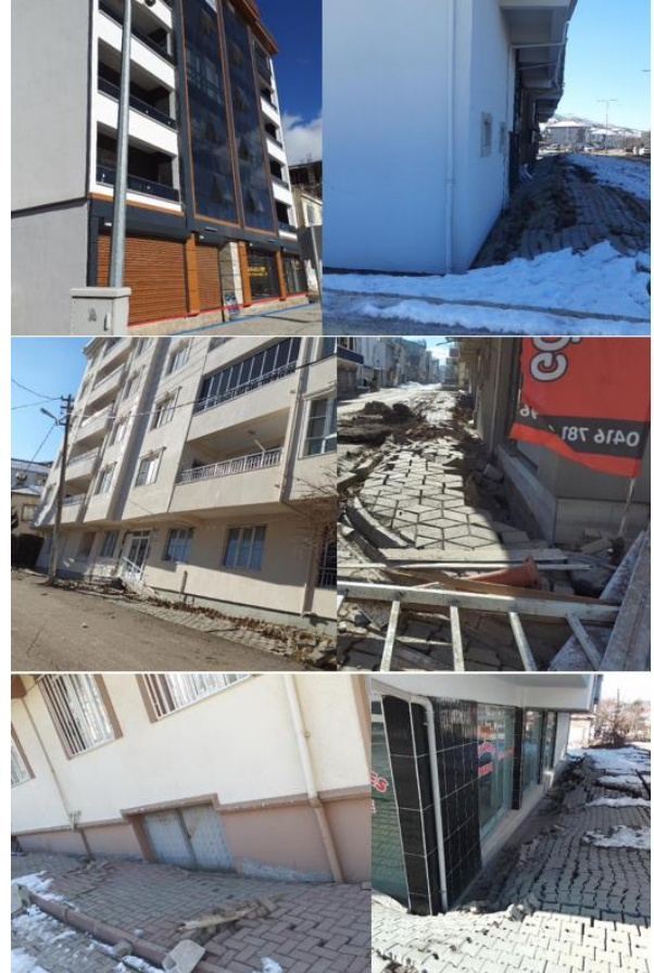
Şekil 1. Adıyaman ili Gölbaşı ilçesinde zemin kaynaklı hasar örnekleri
