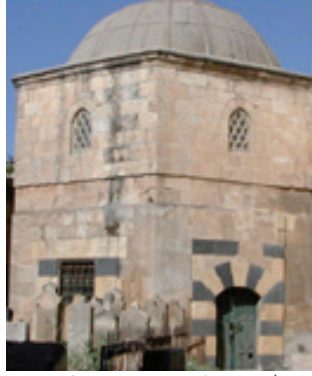
Res. 33. Canpolat Paşa Türbesi 53 (Restorasyon Öncesi)
