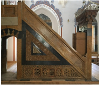
Res. 28. Tekye Cami Minberinin Aynalık Kısım 46 (Restorasyon Öncesi)
