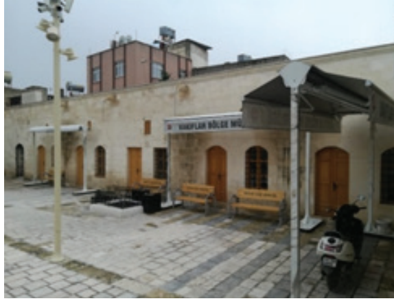
Res. 32. Canbolatoğulları Külliyesi'nden Günümüze Özgün Dokusu Bozularak Gelen Medresenin Batı Kanadı
