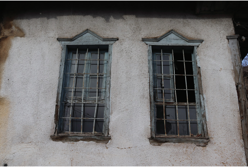
Fotoğraf 34. İstanbulluoğlu Mahallesi, Başçavuş Sokak'ta bulunan Osman Duyar Evi'nin pencerelerinden detay (2022).
