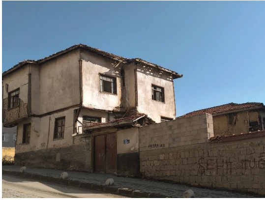
Fotoğraf 52. İstanbulluoğlu Mahallesi'nde bulunan ev (2021).
