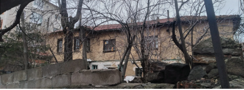
Fotoğraf 7. Aşağı Çatak Mahallesi Eski Sungurlu Caddesi'nde bulunan ayva sarısı renginde bir ev (2022).
