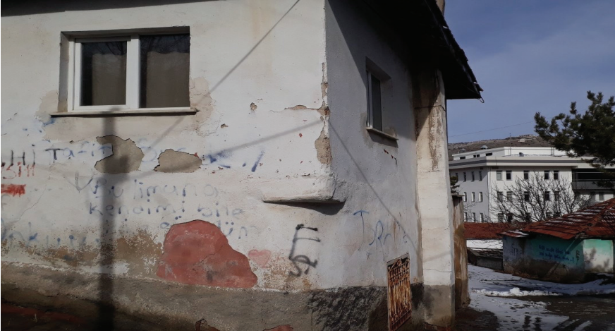
Fotoğraf 17. Develik Mahallesi'nde bulunan pahlanmış köşe örneği (2022).
