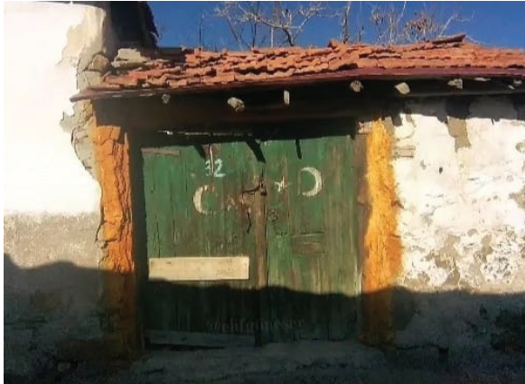
Fotoğraf 19. İstanbulluoğlu Mahallesi’nde bulunan bir avlu kapısı (hacı kapısı) (2022).
