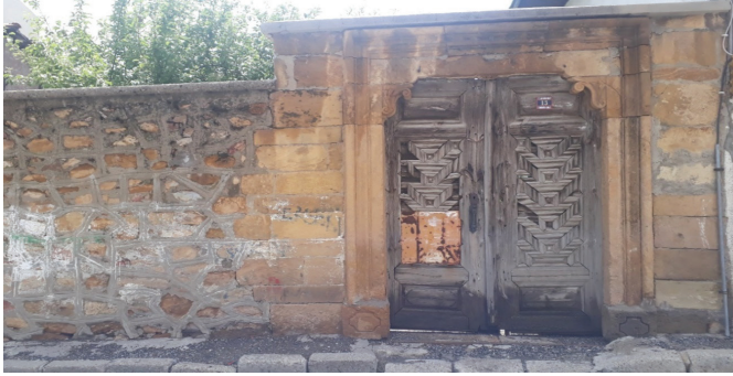
Fotoğraf 20. Çatak Mahallesi'nde bulunan Yenişanlar Evi'nin künde-kârî tekniği ile yapılmış avlu kapısı (2022).
