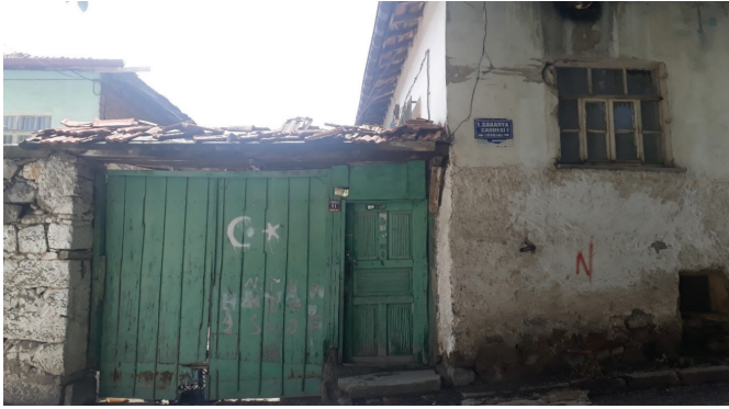
Fotoğraf 21. Çatak Mahallesi'nden avlu kapısı örneği (2022).
