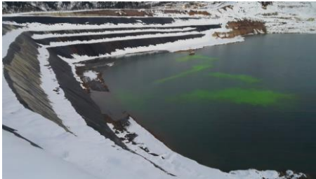
Şekil 4. Atık Baraj alanında değişik lokasyonlarda boyanın deşarj edilmesi
