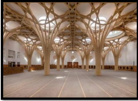
Şekil 5. Endüstriyel Ahşap Çatı Örneği (Coşkun, Yardımlı, 2022).
