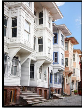
Şekil 6. Ahşap yığma sistem örneği (URL 7).
