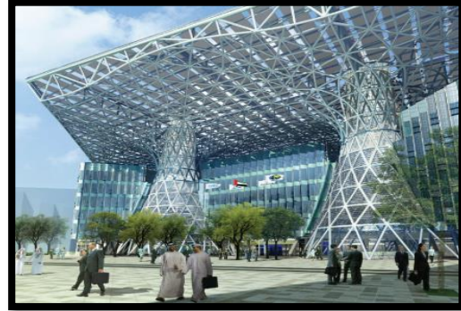
Şekil 12. Masdar Genel Merkezi Strüktür Sistemi (URL 4).
