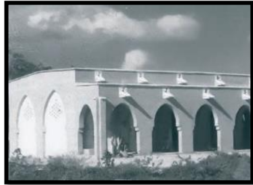
Şekil 8. Kerpiç yığma sistem örneği, Somali okul binası (Acun Özgünler, Gürdal, 2012).
