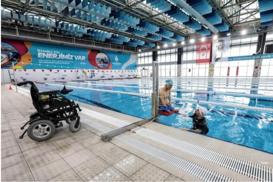
Şekil 7. Havuz hidrolik platform kullanımı (İBB, 2023).
