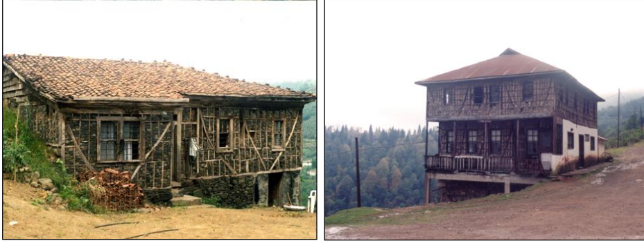
Fotoğraf 7. Çakatura dolma şeklinde inşa edilmiş geleneksel köy meskenleri.
