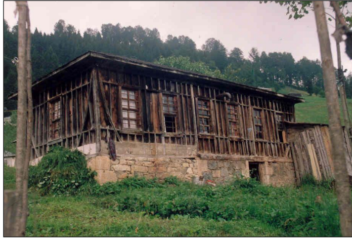
Fotoğraf 4. Alt katı taş, ikinci katı ahşap malzemeden inşa edilmiş köy konutu.
