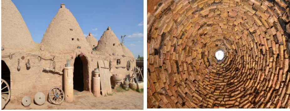
Fotoğraf 10. Çatının kubbe biçiminde yapılması ile ortaya çıkan ve kemer tonozlu ya da kubbe tonozlu ev olarak adlandırılan meskenler, Şanlıurfa çevresinde ve özellikle Harran’da yaygındır.
