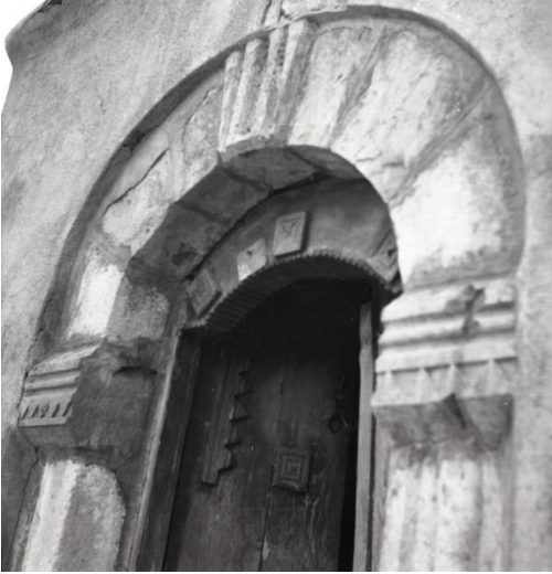
Fotoğraf 16: Onarım Öncesi Kapı Görünümü (V.G.M. Arşivi'nden)
