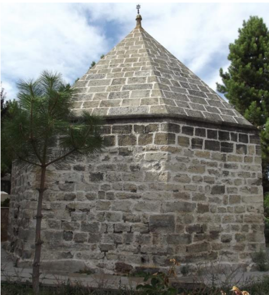
Fotoğraf 4: Güney Cephe, Malzeme ve Örtü Sistemi Görünümü
