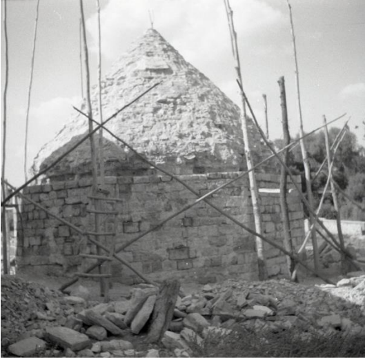
Fotoğraf 6: Onarımlar Sırasında Örtü Sistemi ve Beden Duvarları Görünümü (V.G.M. Arşivi'nden)
