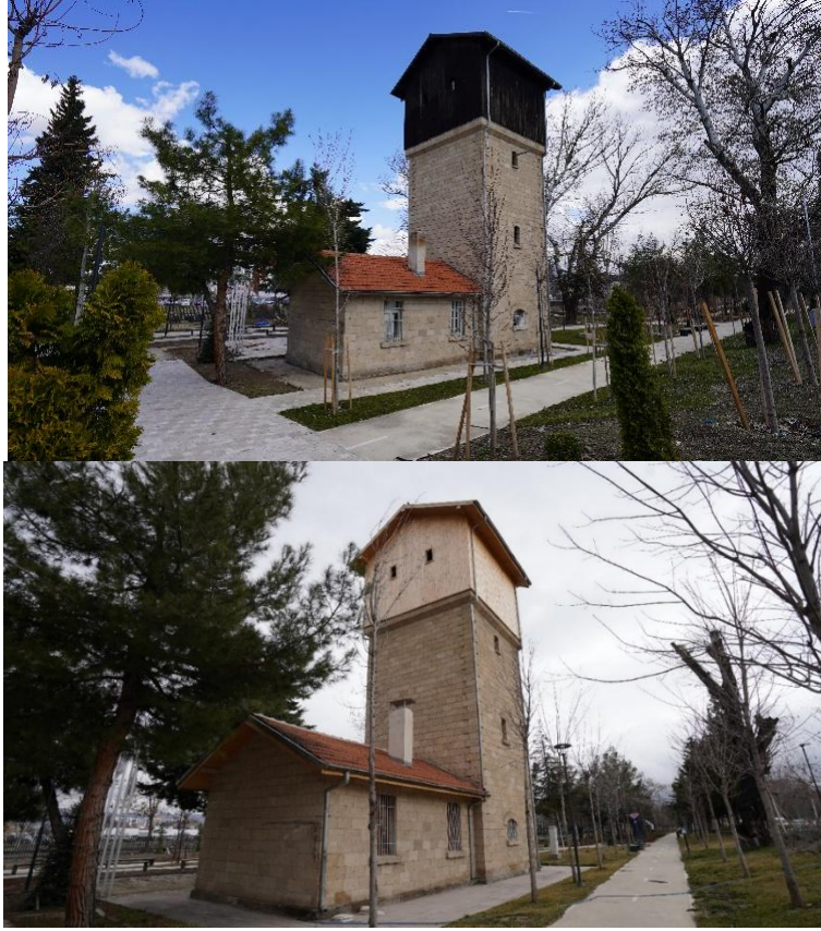
Şekil 9. Su Kulesi Görünümü
