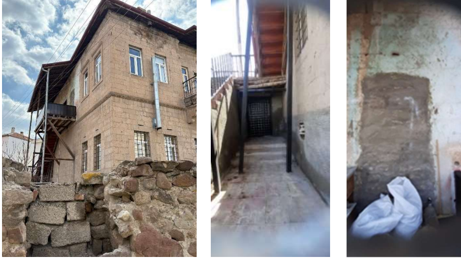
Şekil 10. Hacı Osman Ünsal Evi'nin doğu cephesine yapılan muhdes merdiven ve III. Dönemde doldurulan kapı (Ata Ünsal, 2025; Ata Ünsal vd., 2023: 94)
