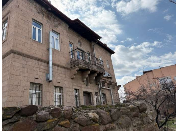
Şekil 8. Hacı Osman Ünsal Evi'nin güney ve batı cephesi payandaları (Ata Ünsal, 2025)
