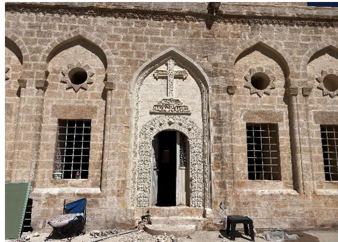
Fig. 15: Birinci kat, güney cephesi sağ yöndeki kapı (2025)
