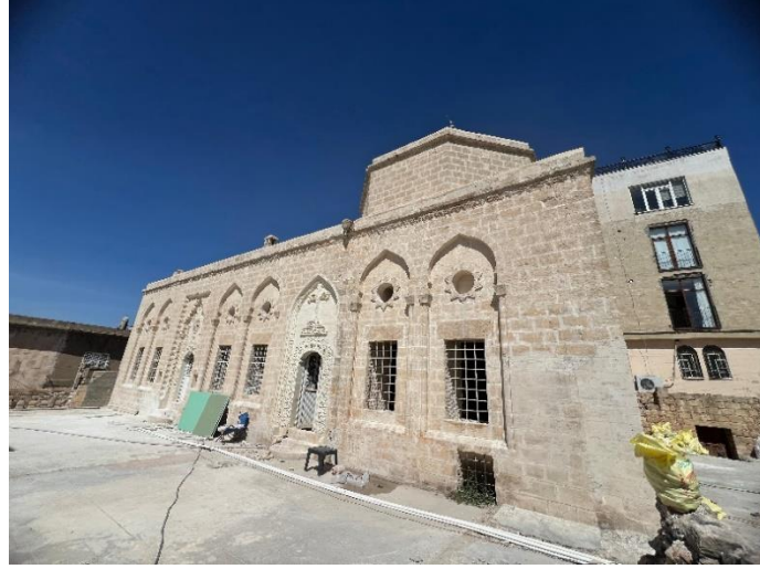
Fig. 13: Birinci kat, teras ve güney dış cephesi (2025)
