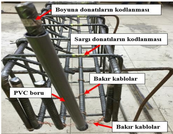
Şekil 5. Bakır tellerin boyuna ve sargı donatılarına bağlanması
