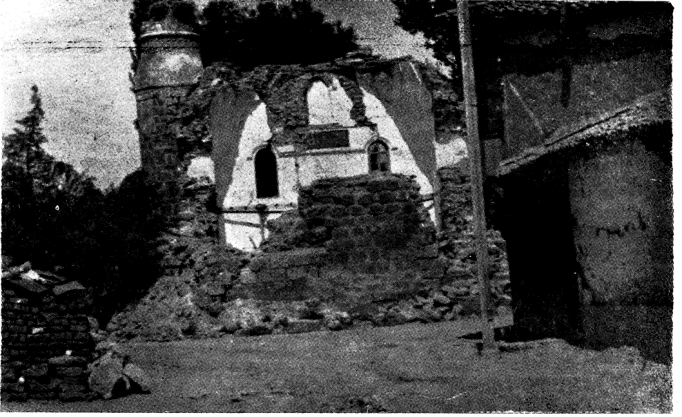
Gönenin depremde yıkılmış olan cami'i
