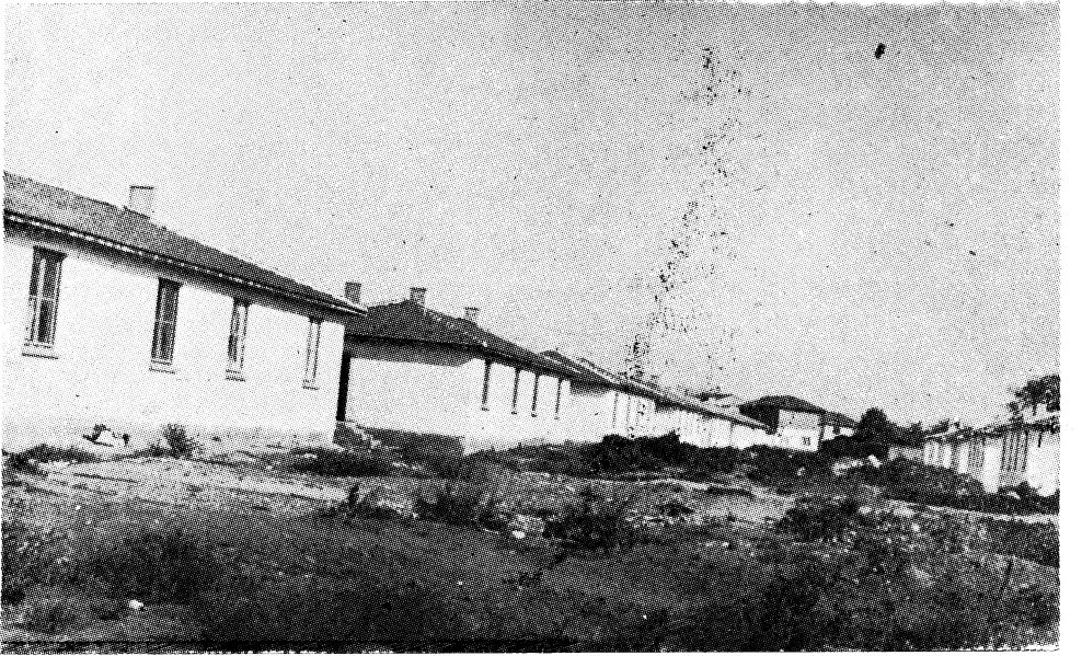
Gönen, Yerdepreminden sonra yapılan banka evleri (70 evler)
