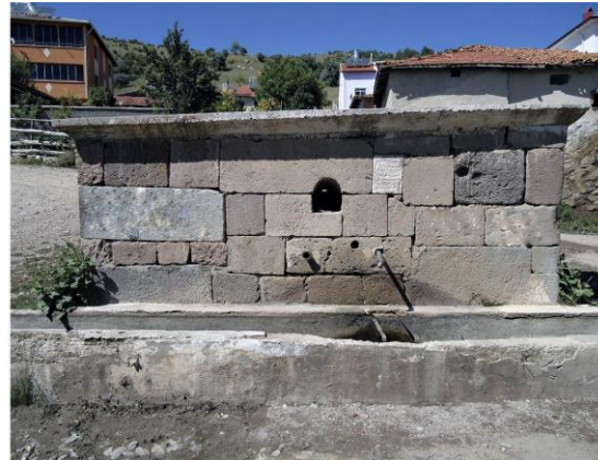
Fig. 9: Çankırı Kayıören Köyü Çeşmesi II (Demirtaş 2022, 282)
