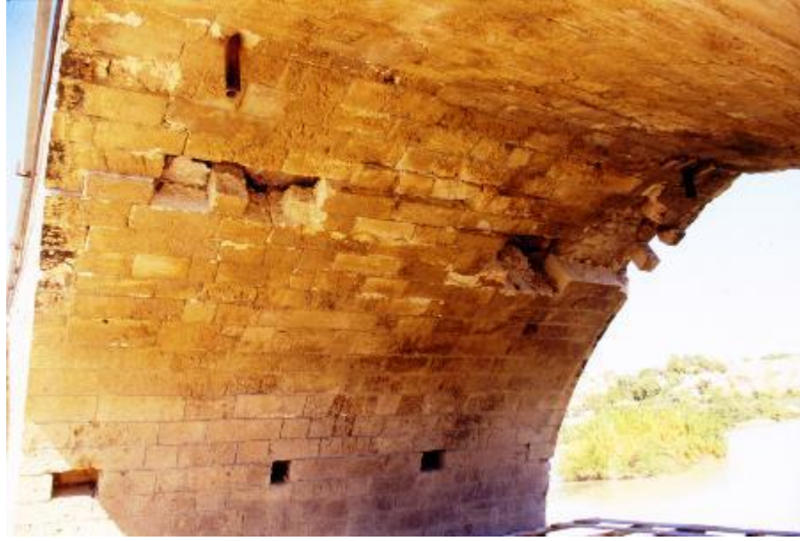
Şekil 6. 7.Açıklık ve Kemerde Hasar (Yeğin, 1998)
