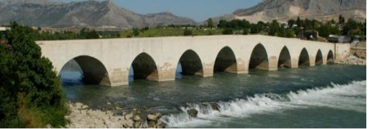
Şekil 11. Misis Köprüsü görünüş mansap (Yeğin 2005)
