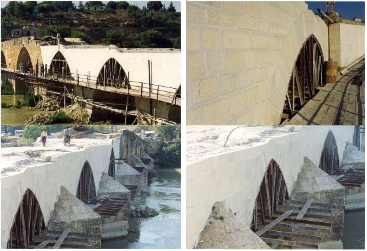
Şekil 10. Köprü Kemerlerinin Restorasyonu (Yeğin, 1998)
