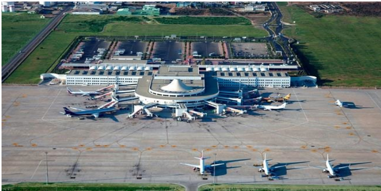
Şekil 1. Antalya Havalimanı dış hatlar terminali (TAV, 2024).
