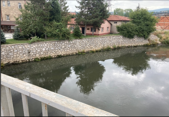
Şekil 6. Orhaneli Çayı üzerinde sel ve taşkın riskine karşı yapılmış ıslah çalışması örneği
