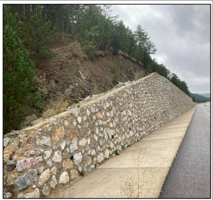
Şekil 5. Havzada kaya düşmesi riskine karşı koyulan uyarı levhası ve akmaları önleme amacıyla yapılan istinat duvarı ıslah çalışması.
