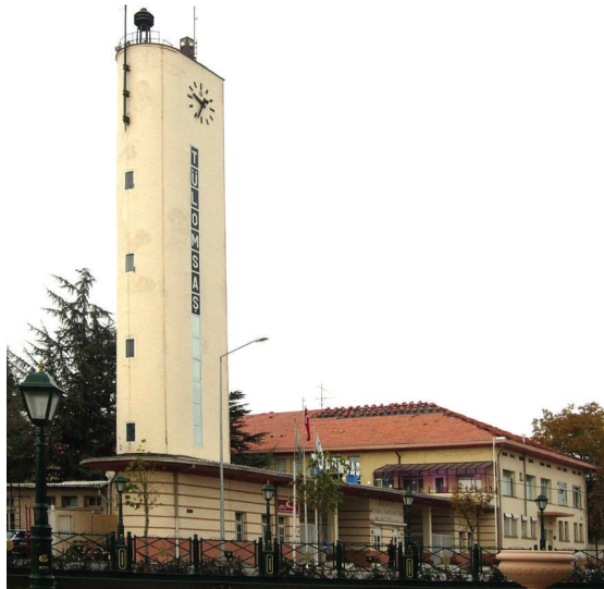
Şekil 23. Bugün TÜLOMSAŞ olarak anılan Eskişehir Cer Atölyesi'nin giriş cephesinden görünüm.
