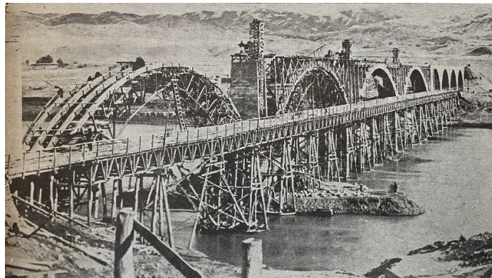
Şekil 3. Fevzipaşa-Diyarbakır hattında köprü inşaatı.
