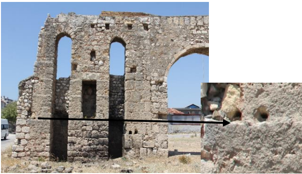
Şekil 10. Alvan Su Kemerî'nde görülen hayvan yuvaları. Figure 10. Nests of animals seen in the Alvan aqueduct.
