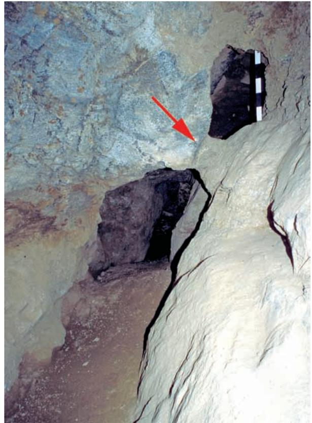
Abb. 7: Karnab, Grube 5-1. Auch im tieferen Bereich des Bergwerks schützten Bergfeste die Bergleute (Pfeil: Reste des Erzgangs).
