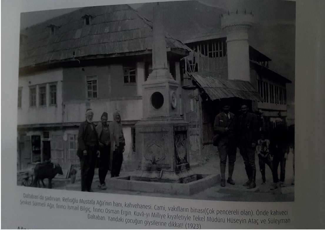
Fotoğraf 1: Gümüşhane, Sadullah Efendi Camii, ilk yapım. 1923 senesinde çekildiği anlaşılan yukarıdaki fotoğrafta cami minaresi ve çok pencereli vakıf binası görülmektedir. ( Gümüşhane Valiliği, Kültür Müdürlüğü Arşivi)
