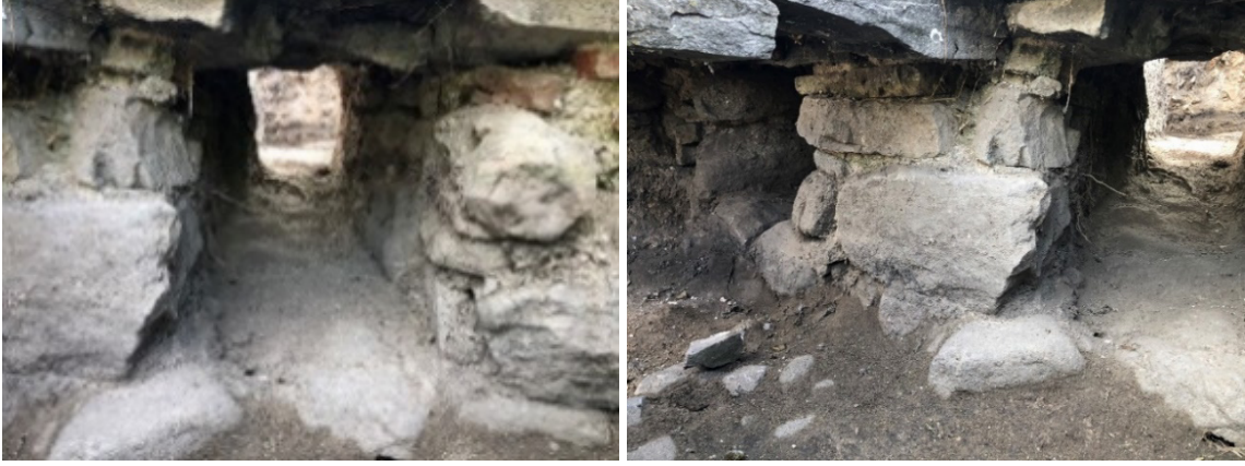
Foto. 24-25. Hamamın külhanından cehennemlik kısmına bağlantı sağlayan kanalların tüteklikten görünümü
