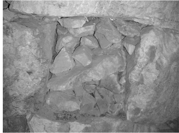
Res. 13: Kült yapısı, içerden ayrıtı: sonradan örülerek iptal edilmiş olan güney penceresi
