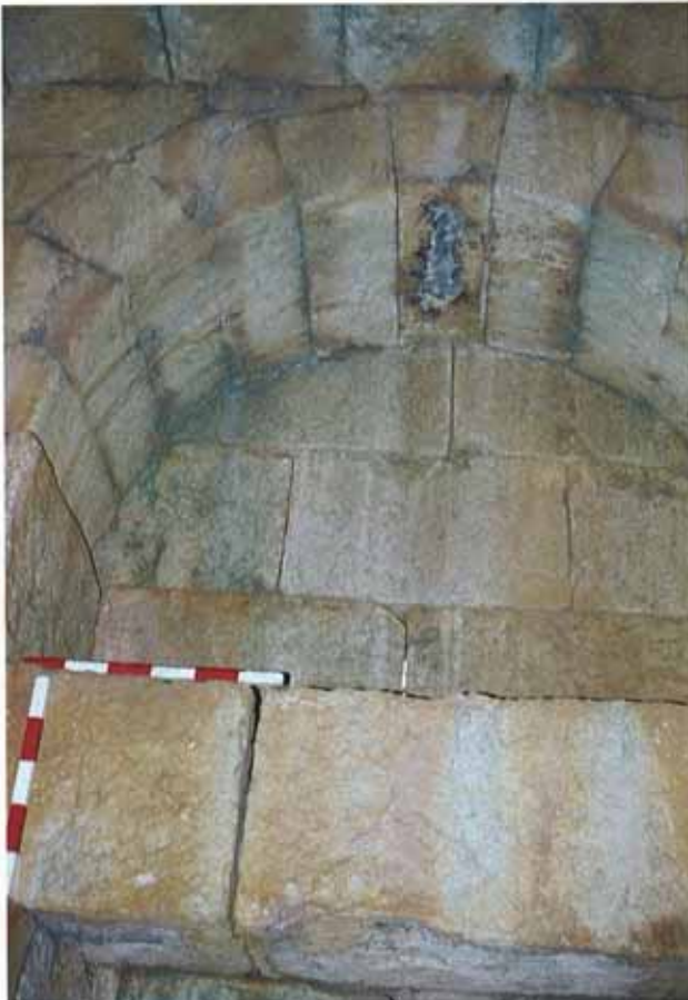
Res. 8: D1 mezar anıtının çatı konstrüksiyonunu oluşturan kemer ve kapama blokları.
