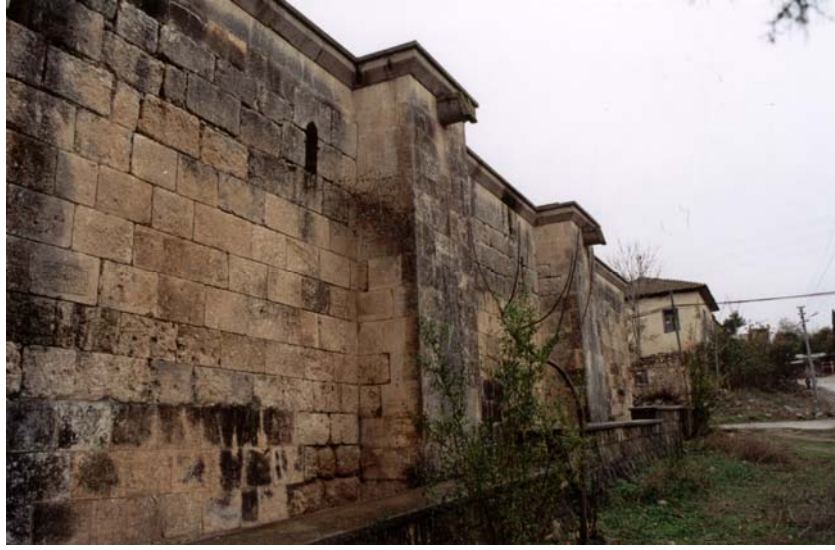
Şekil 8. Yapının Batı Cephesi Payandaları.
