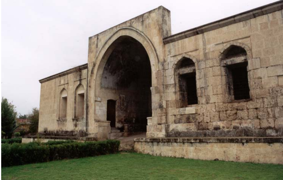
Şekil 4. Yapının Doğu Cephesinde Yer Alan Taç Kapısı.
