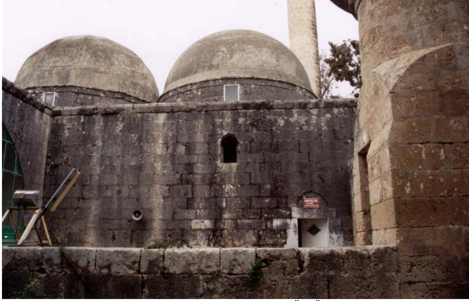
Şekil 15. Kurtkulağı Cami'nin Doğu Cephesinden Üst Örtü Sistemi.
